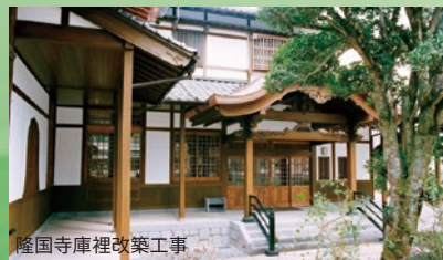
隆国寺庫裡改築工事
