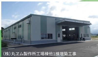
(株)丸エム製作所工場棟他1棟増築工事
