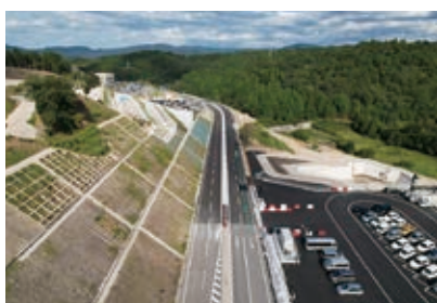
(一)豊岡インター線 道路改良工事 (その12)
