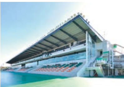
園田競馬場スタンド耐震補強 その他建築工事
