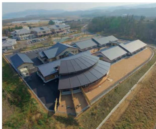
高齢者あんしんサポートハウス夢の郷新築工事
