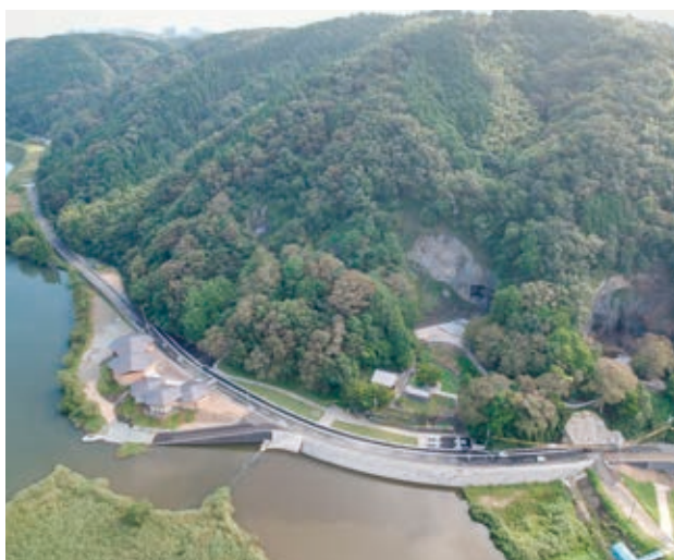
玄武洞公園整備工事(第1工区)
