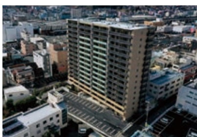
(仮称)福知山駅前計画新築工事 (JV)
