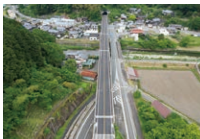
(国)178号森本高架橋橋梁補修工事 (その4)
