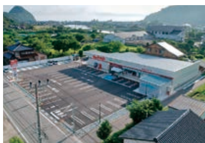
ミニフレッシュ竹野店新築工事
