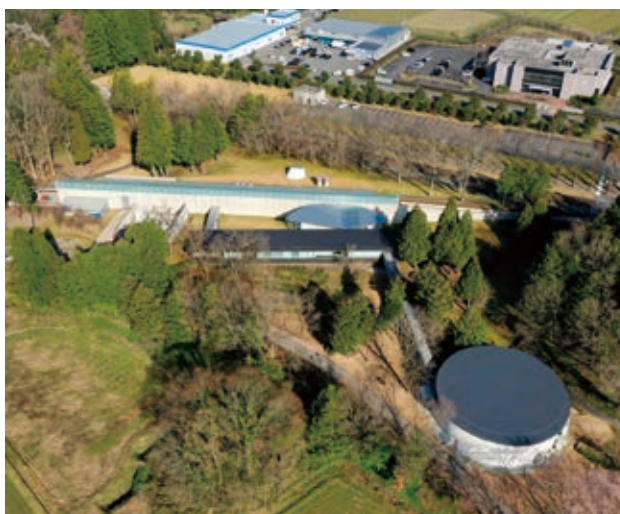
植村直己冒険館機能強化改修工事
