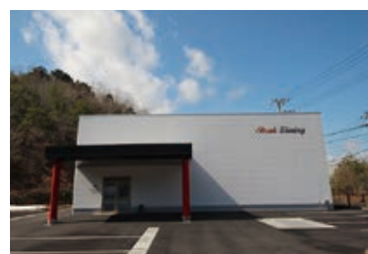
オフテクスHDカフェテリア新築工事
