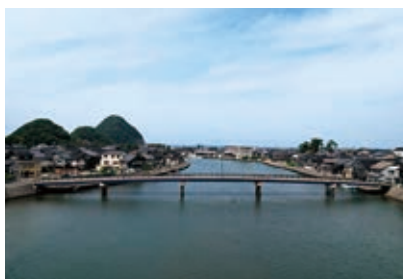
竹野橋橋梁補修工事(その3)
