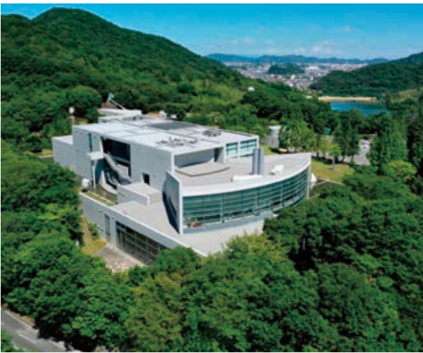
こどもの館本館外計画修繕建築工事
