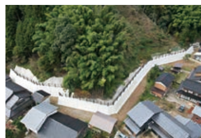
(急)下塚(1)地区 急傾斜地崩壊 対策工事
