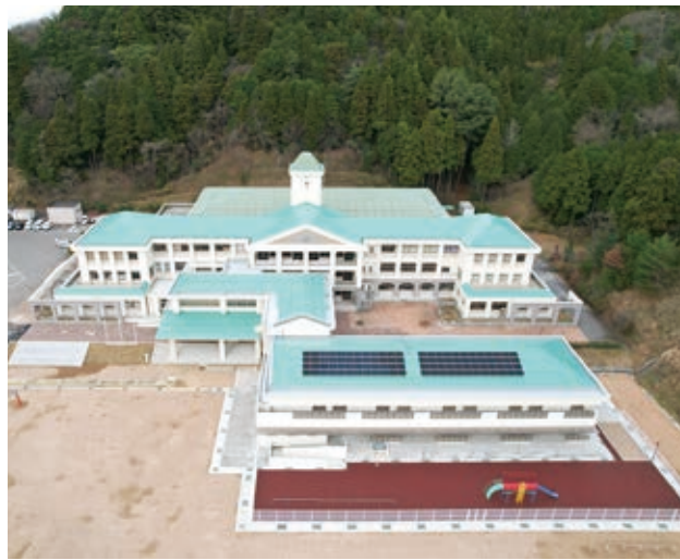
竹野地域小中一貫校整備建築工事
