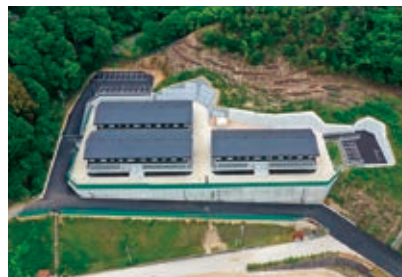
西脇馬事公苑きゅう舎新築工事
