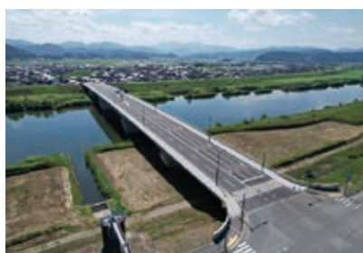
(国)426号円山大橋橋梁補修工事 (その1)
